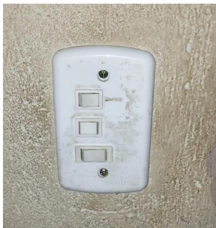
Além disso conta com a “gambiarras”, que foram feitas na instalação do ar condicionado, fazendo a tomada do lado da entrada não funcionar mais. O principal motivo para ter ocorrido isso foi por conta que não existe uma aviação própria, fazendo que conectasse com outro cabos existentes, ocasionado no mau contato.
