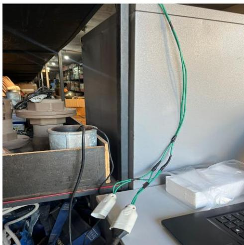
Imagem 2: Instalação de tomada inadequada.
